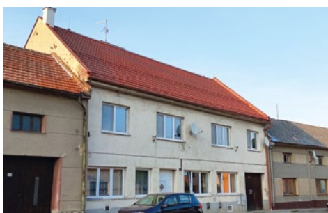
Střecha ul. Brodecká 74
