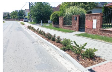
Silniční obruby Olomoucká
