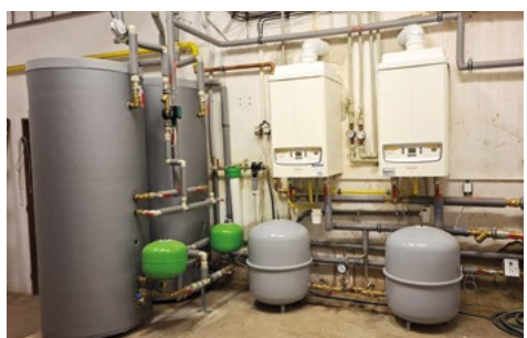
Nový kotel Brodecká č. p. 80
