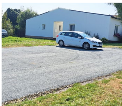
Komunikace k malometrážním bytům
