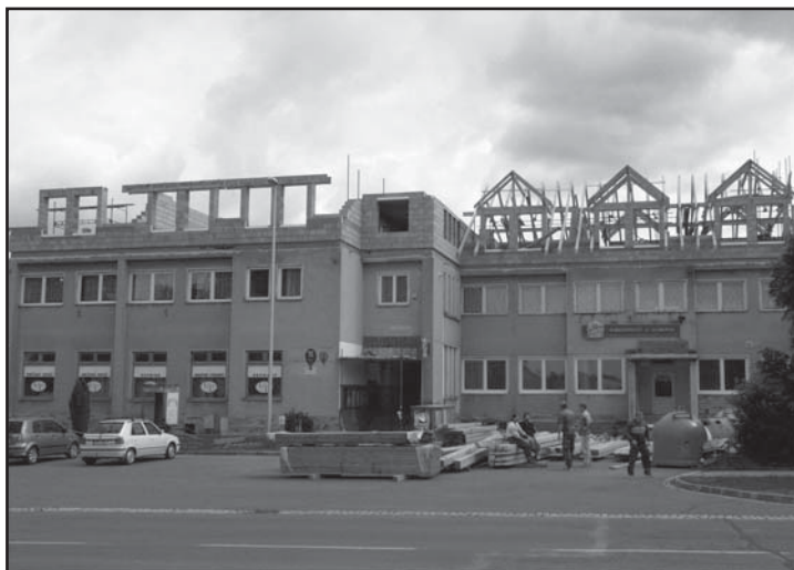
Nástavba budovy ÚM
